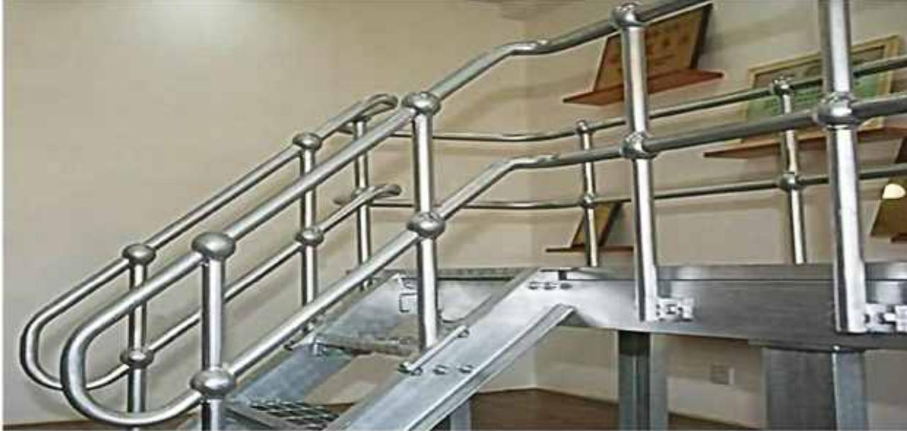
Lapisan HDG merefleksikan kondisi permukaan dan metalurgi dari baja. Gambar diatas menunjukkan besi yang telah difinishing menghasilkan lapisan HDG yang sangat halus dan merata.
